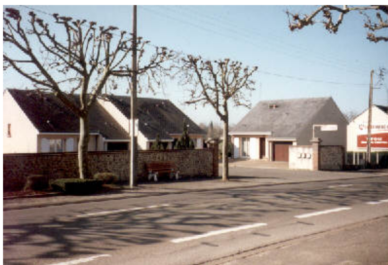
Entrée du Centre de secours et logements des pompiers
